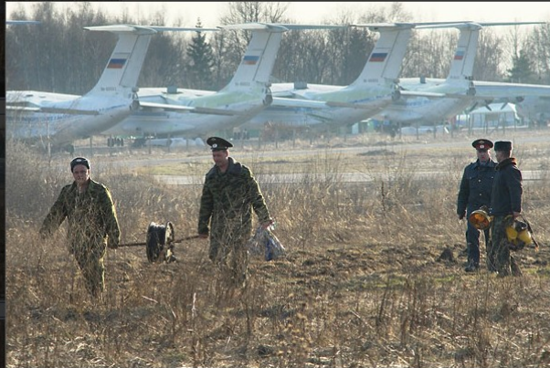
Военные тянут кабель к посадочным фонарям перед взлетно-посадочной полосой. Фото Сергея Серебро
